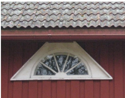
Fönster och tegeltak på flygelbyggnaden.
