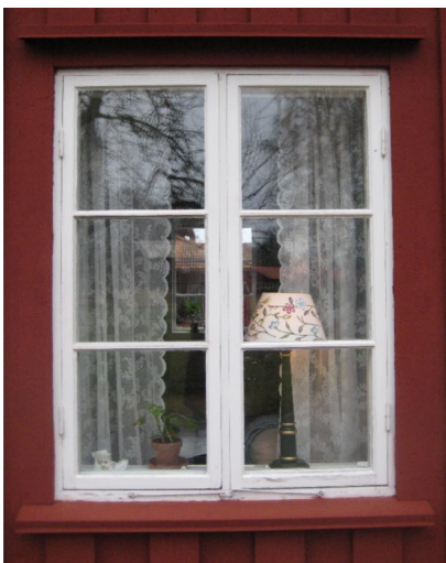
Fönster på flygelbyggnaden.
