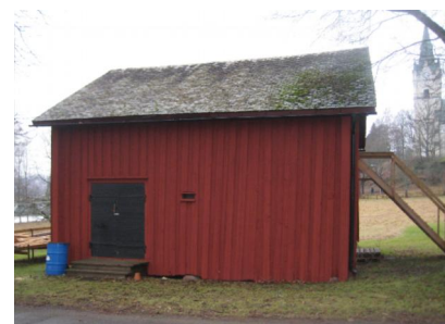
Bod på norra sidan om huvudbyggnaden.
