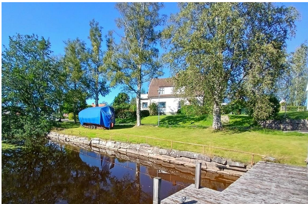
Figur 5. Strandzonen vid Frykensundet öster om planområdet. Slätten är bevuxen med gräs och träd, och strandlinjen är förstärkt med erosionsskydd i sten. Inga tecken på pågående erosion har observerats.
