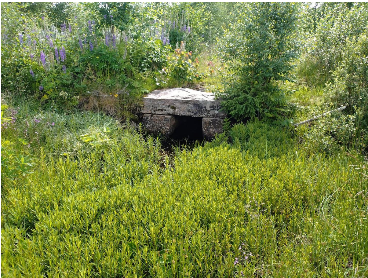
Bild 14; Bäckens passerar genom en stentrumma under en gångväg. Bilden är från juli 2025 då vattennivåerna inom området var låga.
