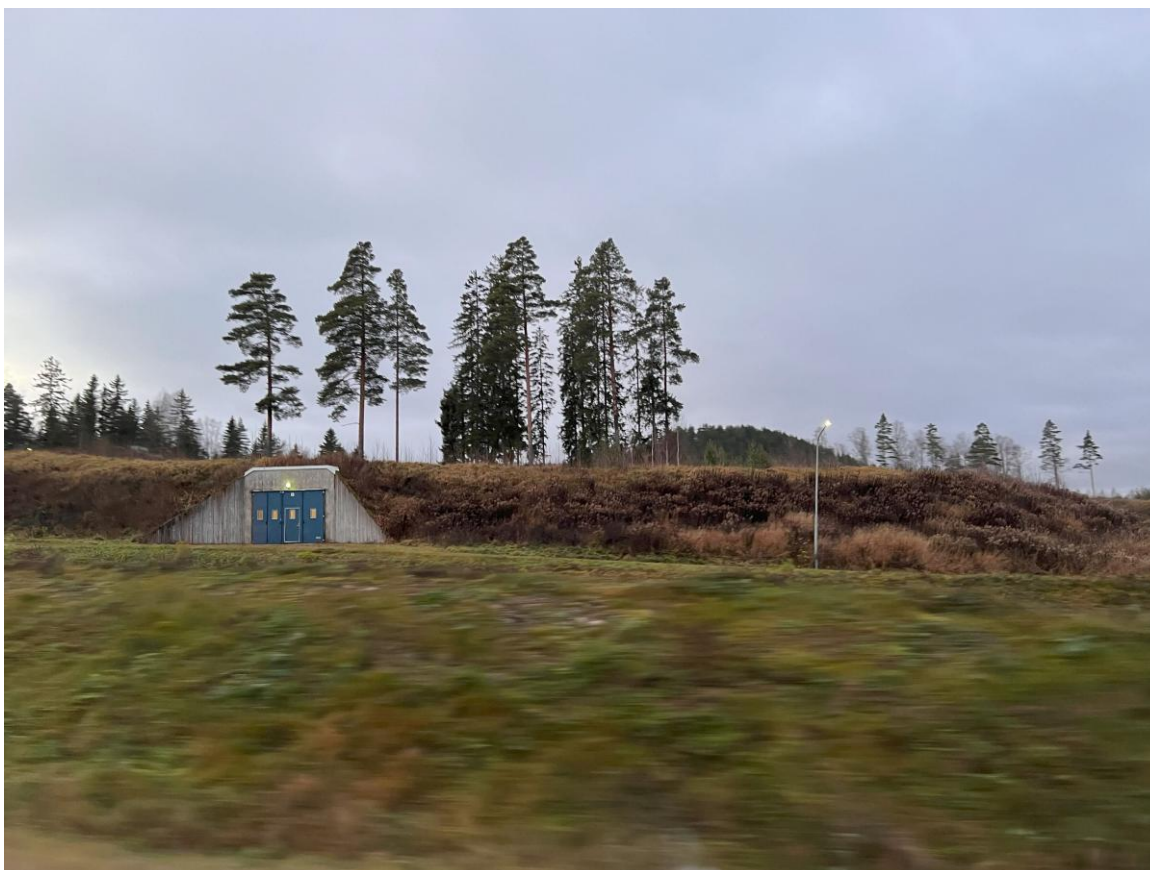
Figur 3: Referensbild som visar del av Torsby skidtunnel.
