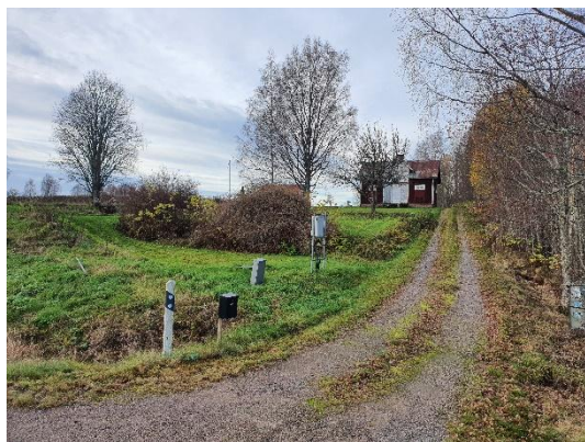
Urschaktningen och pumpstationen sett från E45. Marken där gång- och cykelvägen planeras sluttar förhållandevis brant ner mot pumpstationen.
