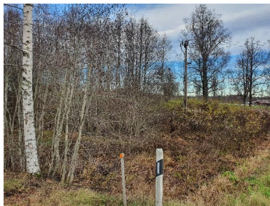
Det sankta partiet med bäcken/surdraget omedelbart norr om avtagsvägen upp mot Ulvsby 1:66 där ny bank måste anläggas.
