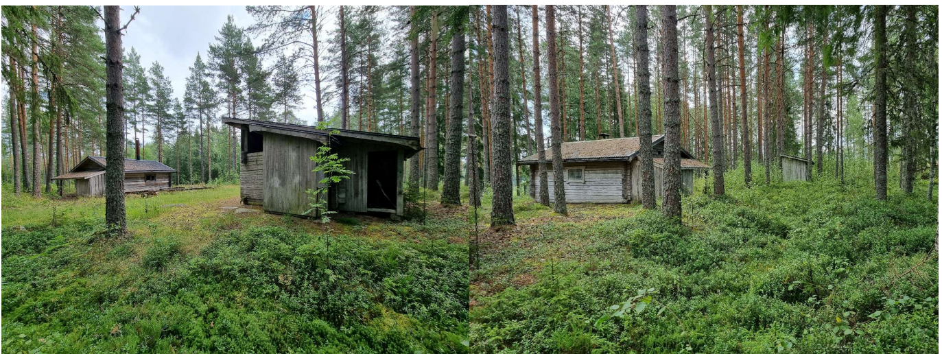
Figur 6. Vy från placeringen av autobox 3. Grillstuga och förråd till vänster och övernattingsstuga och dass till höger.
