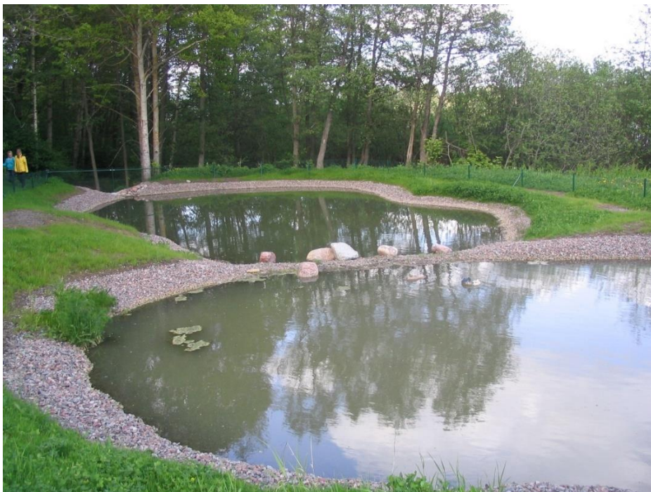
Figur 23. Dagvattendamm med förbyggning. Bild: Sweco.
